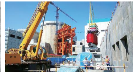
某建设项目配电设施完善的干式变压器安装
