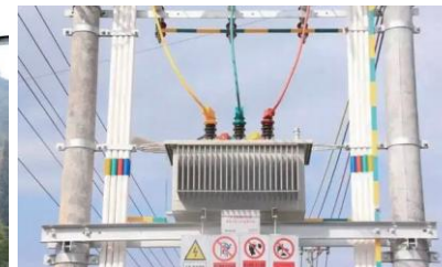
公路线杆油浸变压器安装
