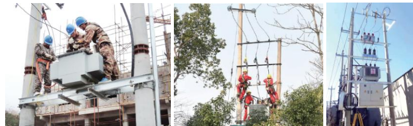
室外线杆油浸变压器安装一
