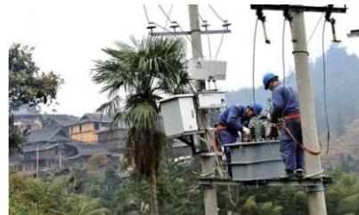
乡村线杆油浸变压器安装
