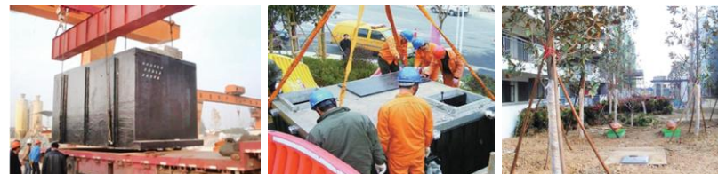
预制全埋箱变运送至现场
