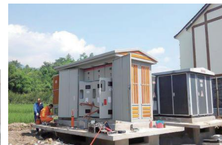
某厂房欧变安装
