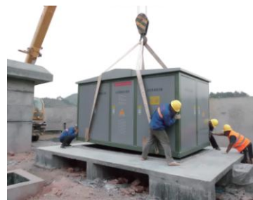
某工程建设用电欧变安装
